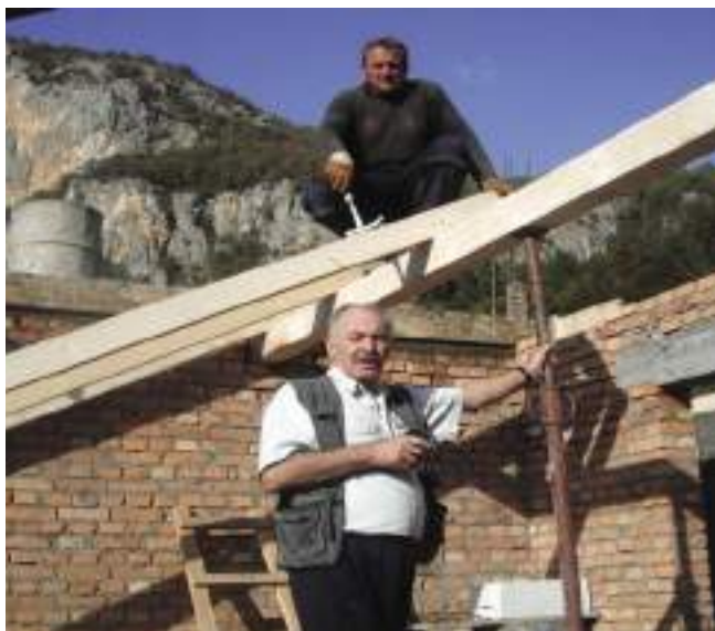
Славко Жупански на изградњи објекта
