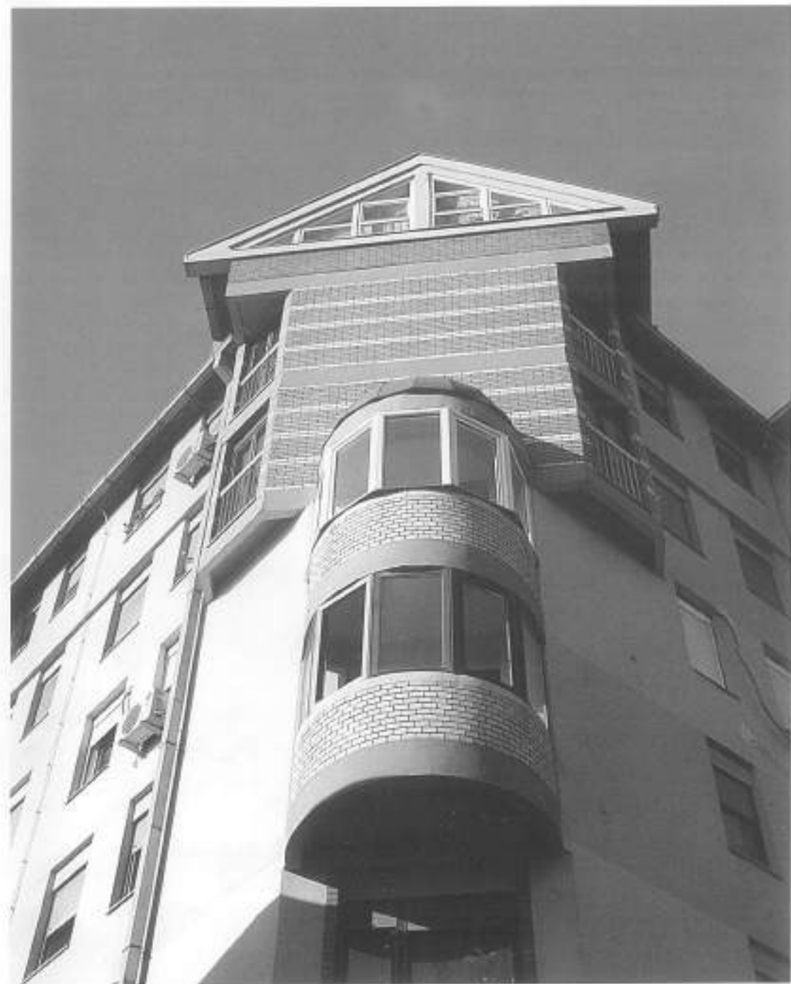
Stambeno poslovna zgrada u Rumenačkoj ulici (1996)
