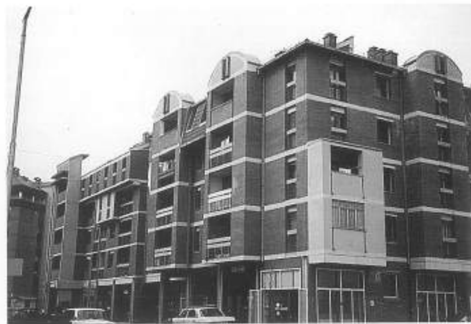
Stambeni blok 4 na Novom naselju, 1991.
