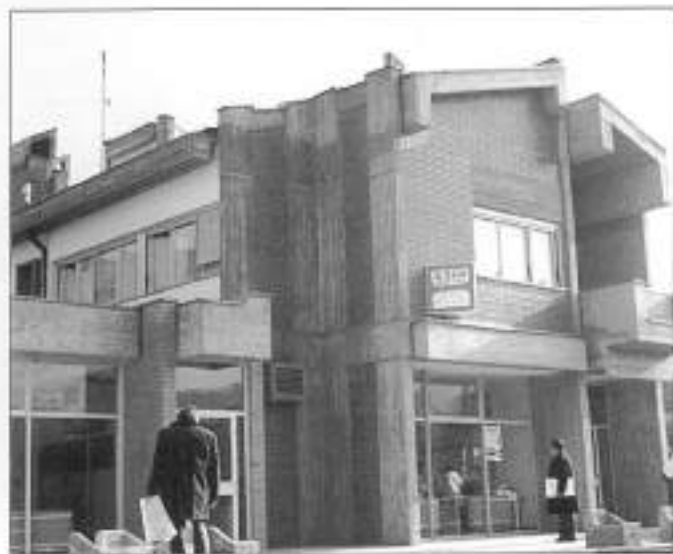
Bukovac, stanbena zgrada sa lokalom
