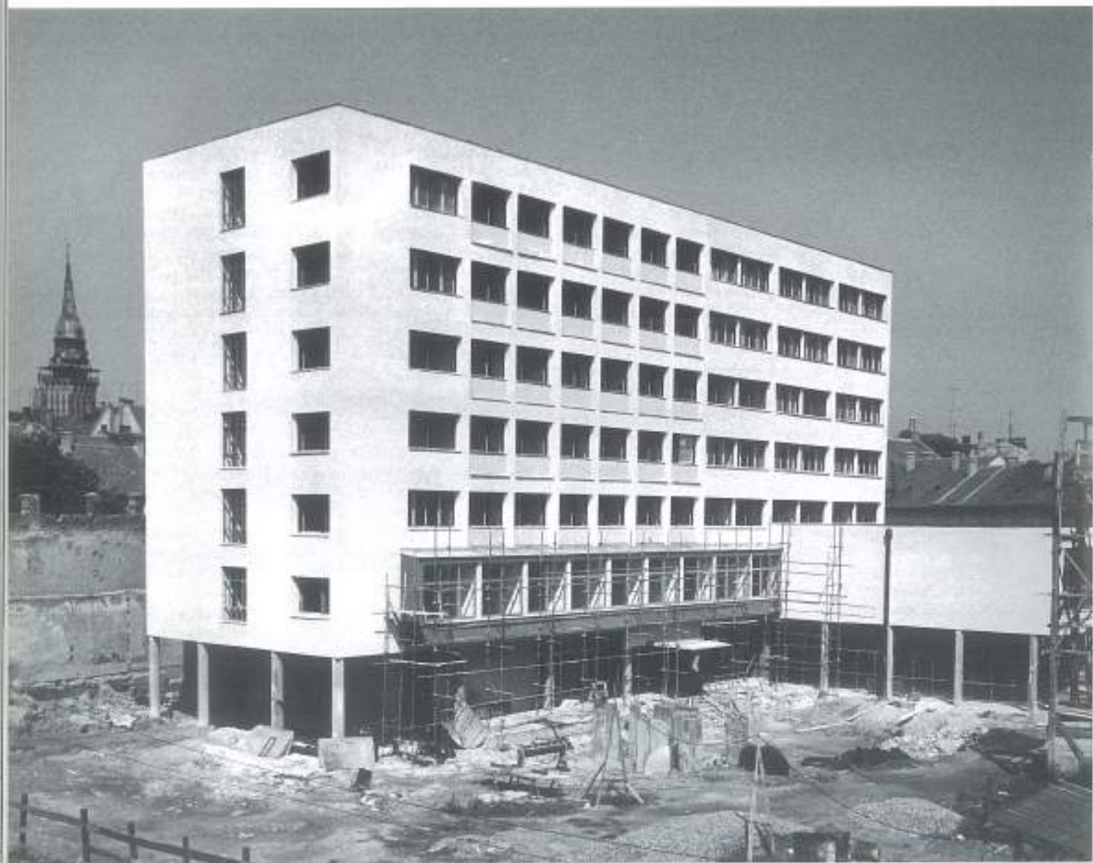
Hotel "Patria" ("Palić"), Subotica, u izgradnji (1963)
