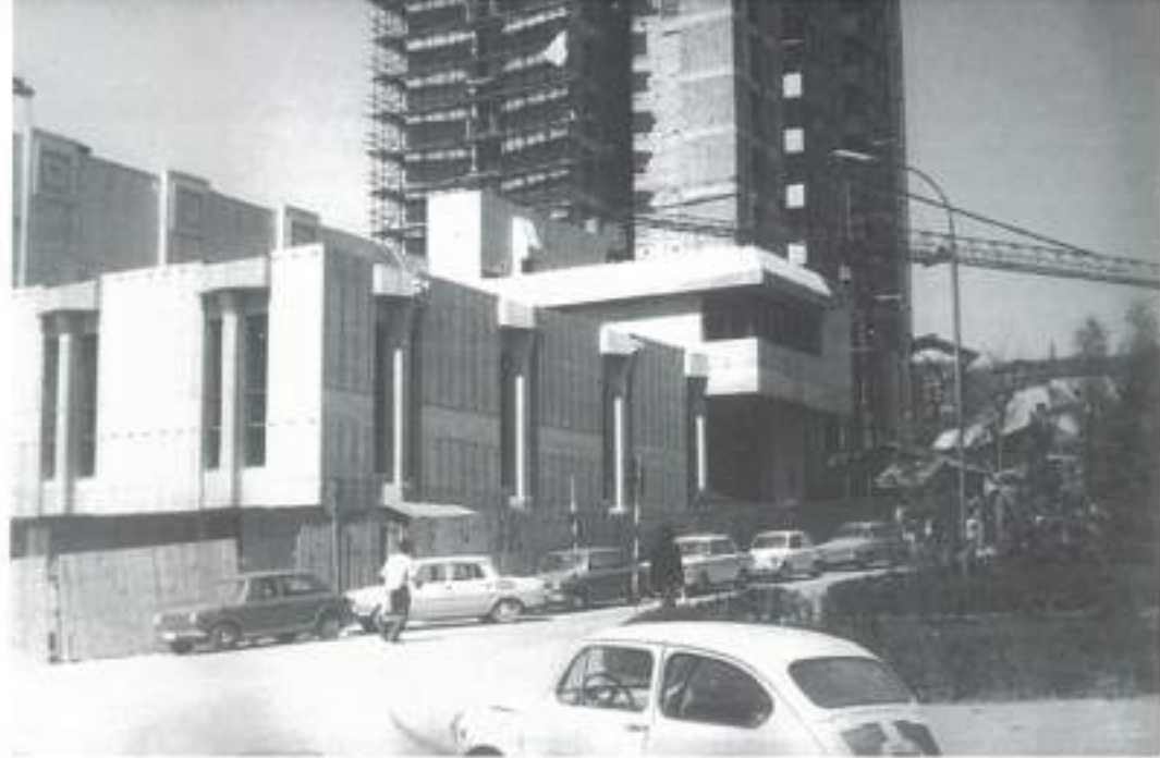
| Transitna automatska telefonska centrala, Ušice
