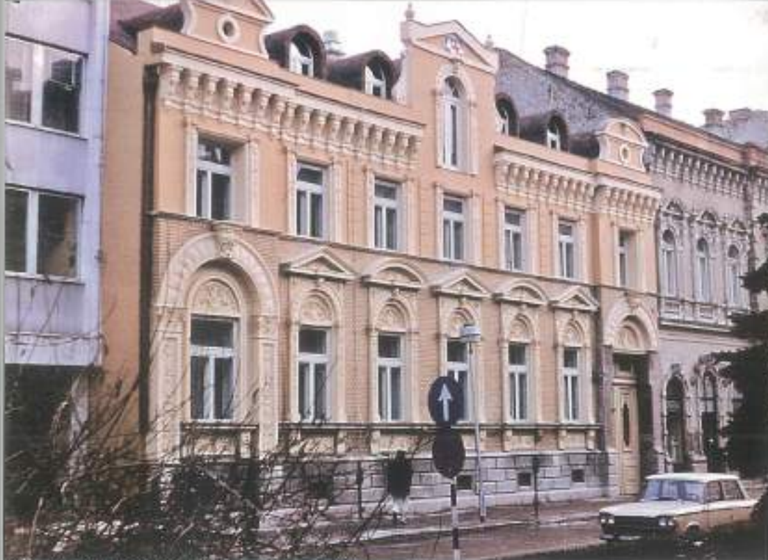
Надоградња пословног објекта "ЗВЕЗДА", 1988.год, Нови Сад
