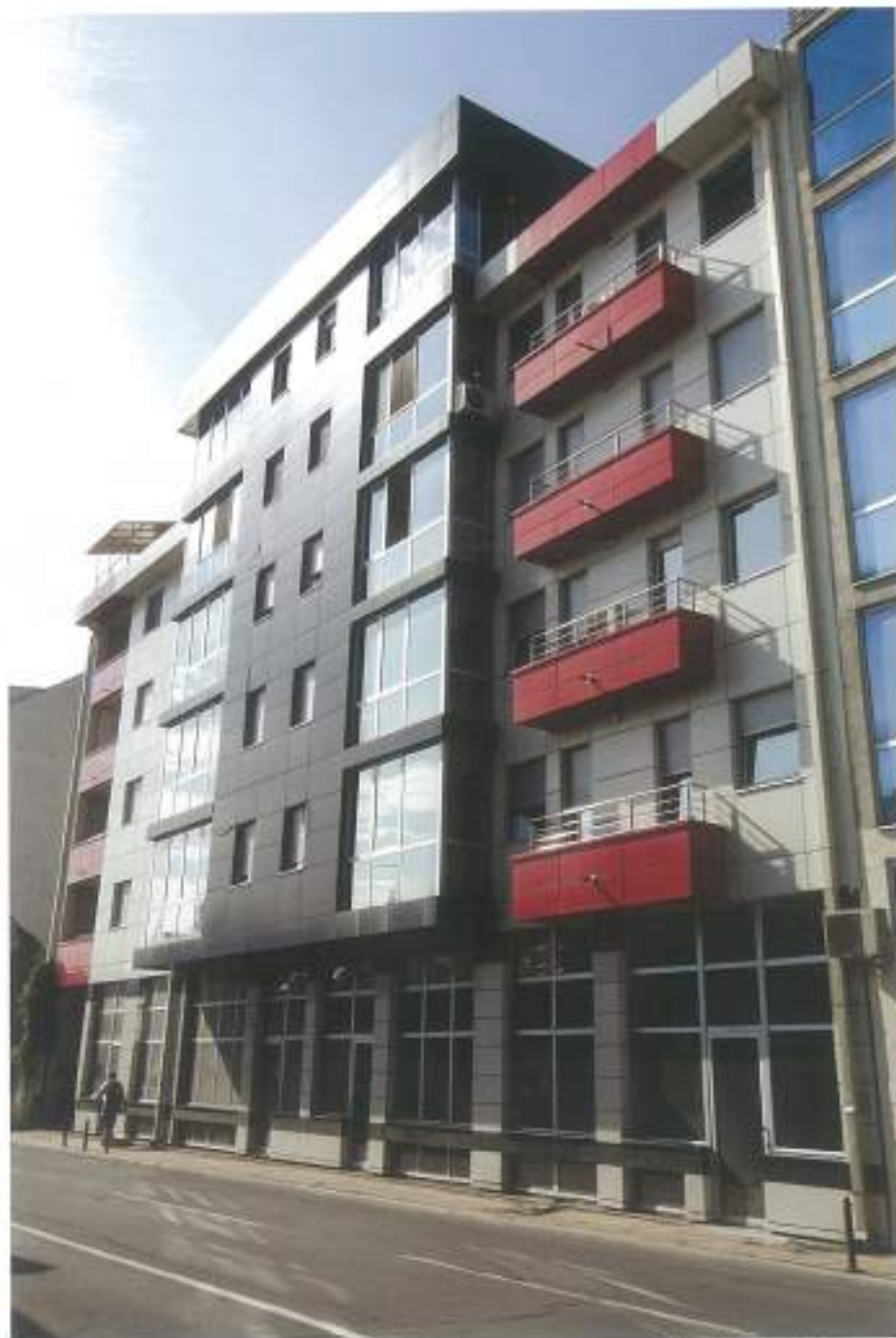
2010. (2011) Stambeno-poslovni objekat, Ulica Jovana Subotića br. 19. Su+P+4+Pk, (Verting Mijanović)
