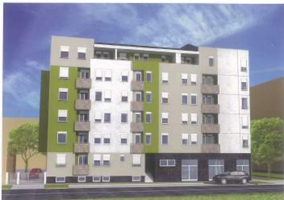
2013. (u izvođenju) Stambeno-poslovni objekat, Rumenačka ulica br. 142 P+G+4+Pk, (Galens)
