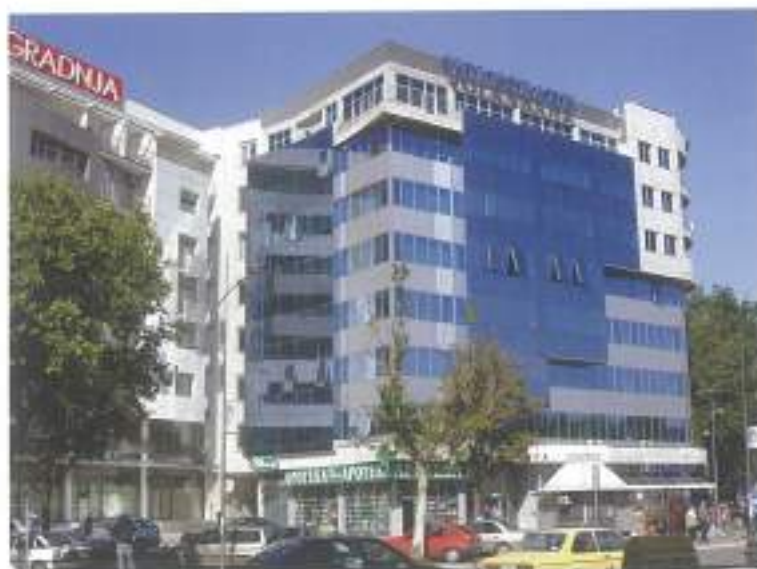
2003. (2004) Poslovni centar 'Metalno'. Ugao Bulevara oslobođenja i Futoške ulice
