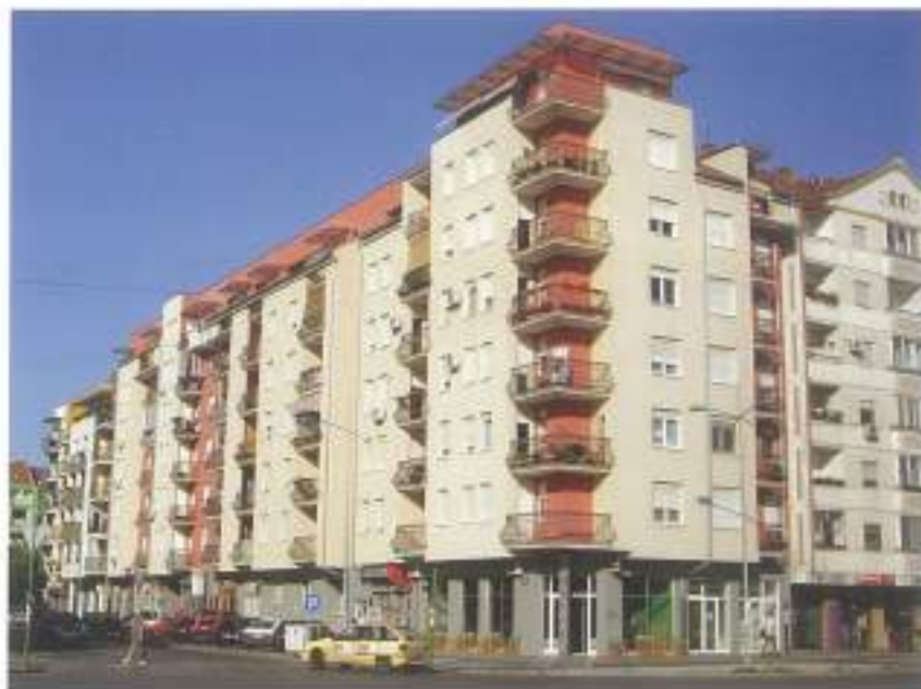
2007. (2009) Su+P+4+Pk, (Termometal) Ugao Ulice Janka Veselinovića i Rumenačke ulice
