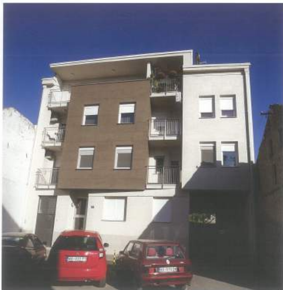
2010. (2011) Stambeni objekat. Ulica Arse Teodorovića br. 10, P+2+Pk, (Dinamika)
