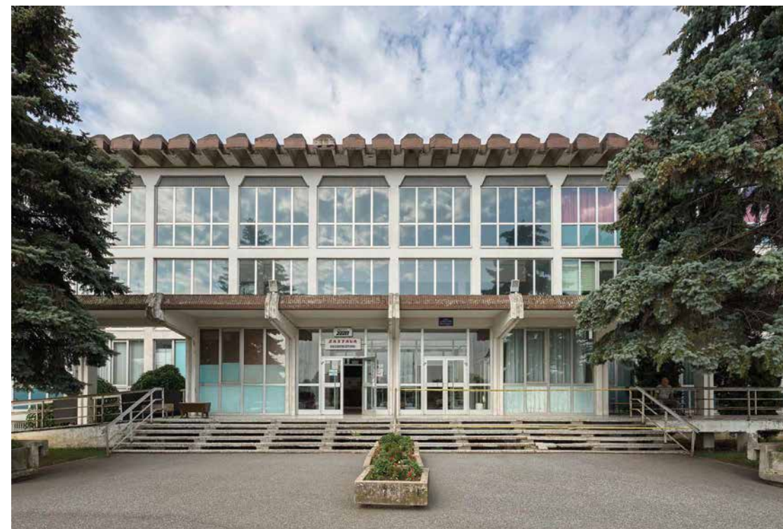
Zavod za zdravstvenu zaštitu radnika – Zastavina ambulanta Arhitekta: Dr Veroljub Atanasijević; Godina izgradnje: 1978. Foto: Relja Ivanić
