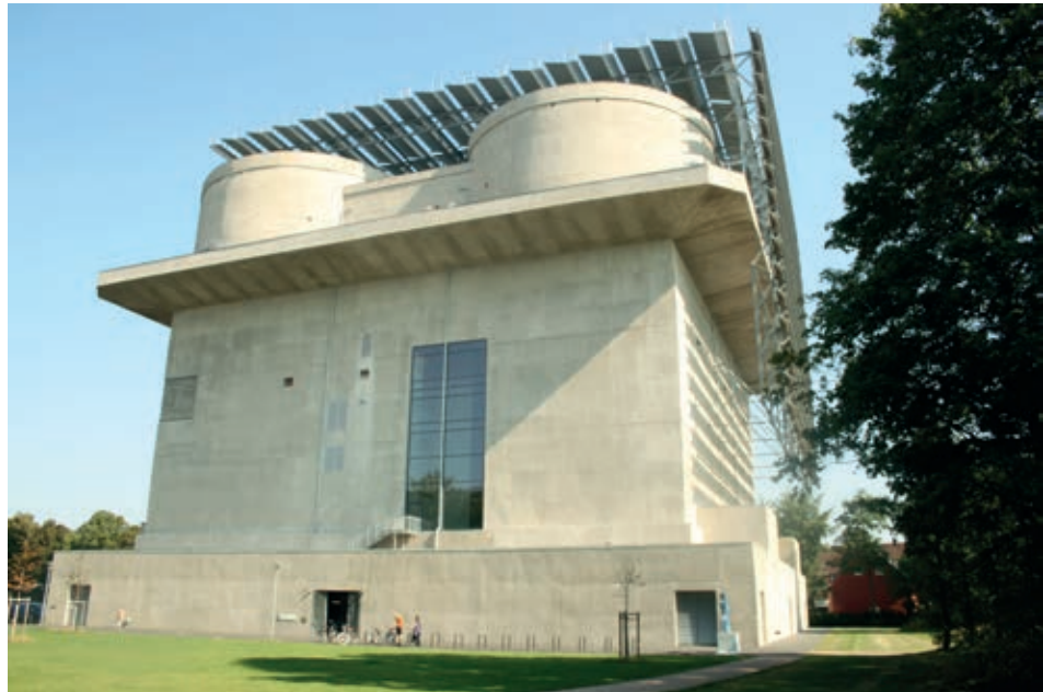
Fotografija © Dušan Prodanović, nekadašnji bunker pretvoren u solarnu elektranu.
